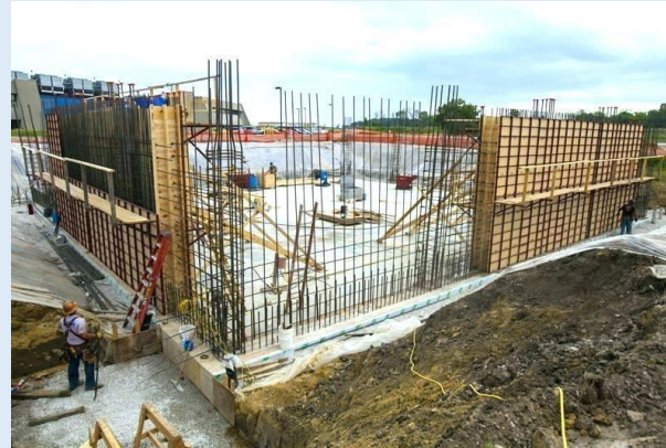
Errichtung von Grundmauern auf einer Baustelle
