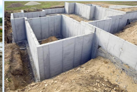
Errichtung von Grundmauern auf einer Baustelle
